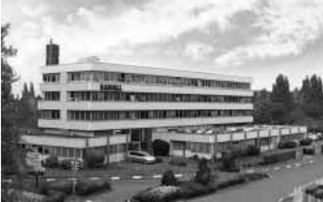
Head Office - Rosny sous Bois
